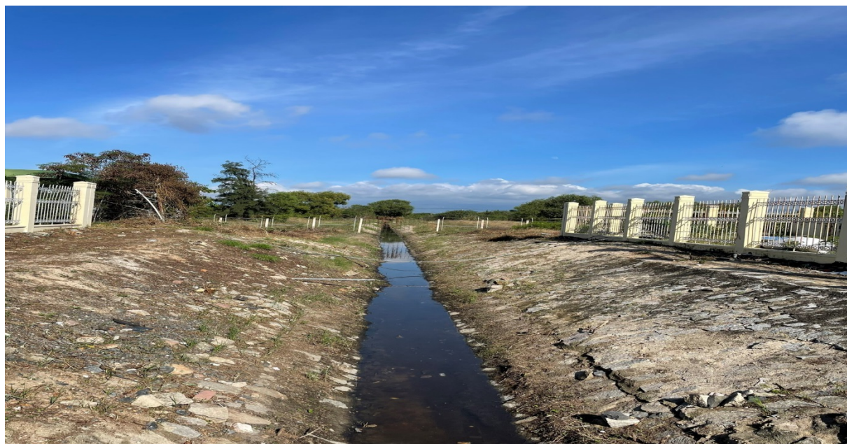
Hình 3. 10 Mương thoát nước của cảng hàng không
