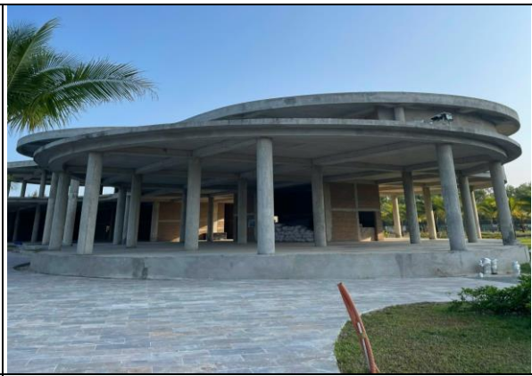
Khu nhà hàng biển đang hoàn thiện
