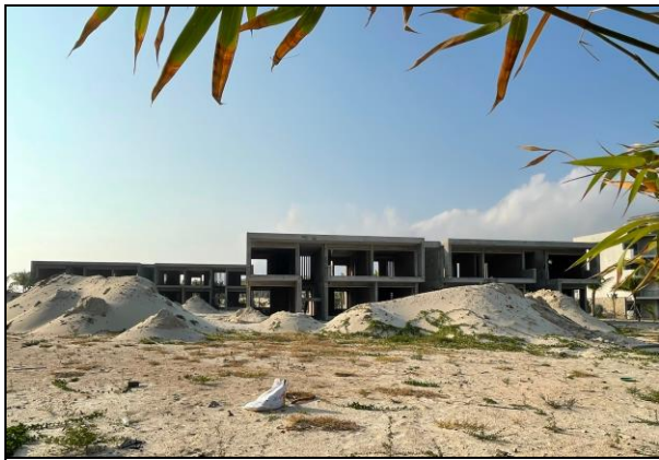
Khu biệt thự 2 tầng đang hoàn thiện
