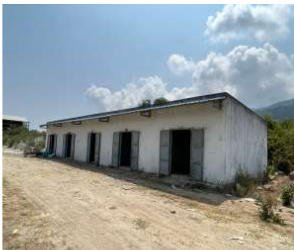
Hình 3.18: Kho lưu trữ chất thải rắn công nghiệp.
