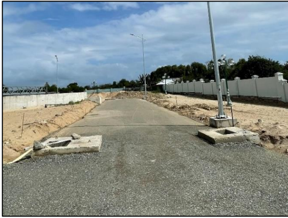
Hố ga thu nước mưa trong nhà máy
