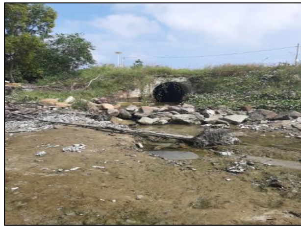
Cống thoát nước mưa trên đường K10 ra đầm Thủy Triều
