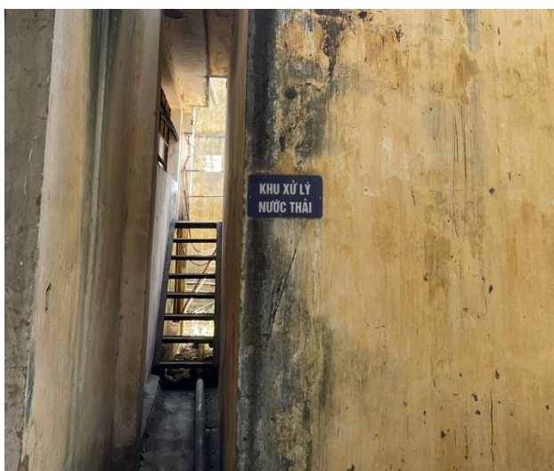
Hình 3. 4 Khu xử lý nước thải
