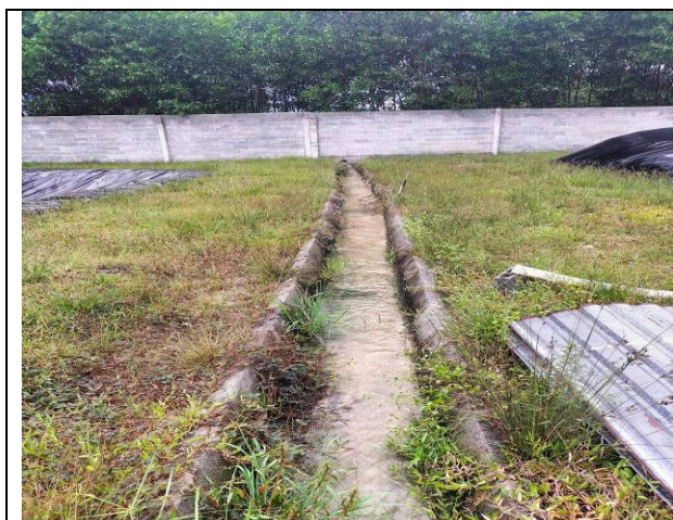
Hình 4.4. Mương hở thoát nước
