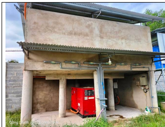
Hình 1.2. Bể chứa nước PCCC 20 m 3
