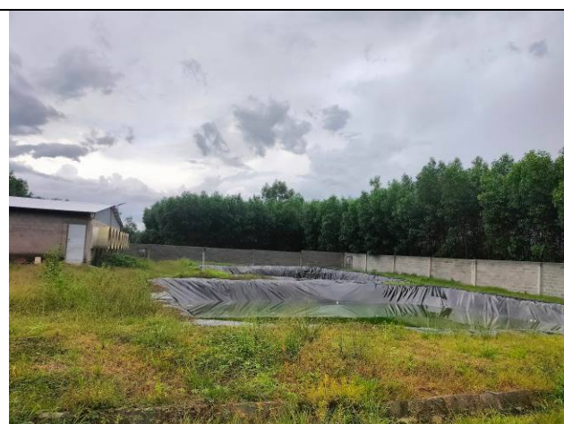
Hình 4.6. Bể lắng 1; bể lắng 2; Ao chứa nước thải sau xử lý
