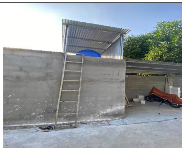
Hình 1.3. Bể chứa nước sinh hoạt 5 m 3
