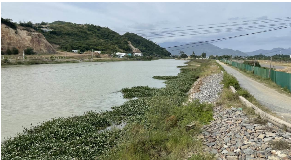
Hình 1. Kè sông Tắc phía thượng lưu cầu sông Tắc thuộc Dự án Hệ thống thoát lũ từ cầu Phú Vinh đến đầu cầu sông Tắc đã xây dựng
