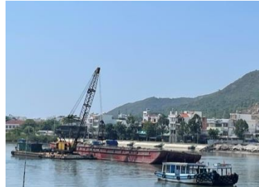
Đổ vật liệu nạo vét lên sà lan, để khô ráo, vận chuyển đến bến nhô
