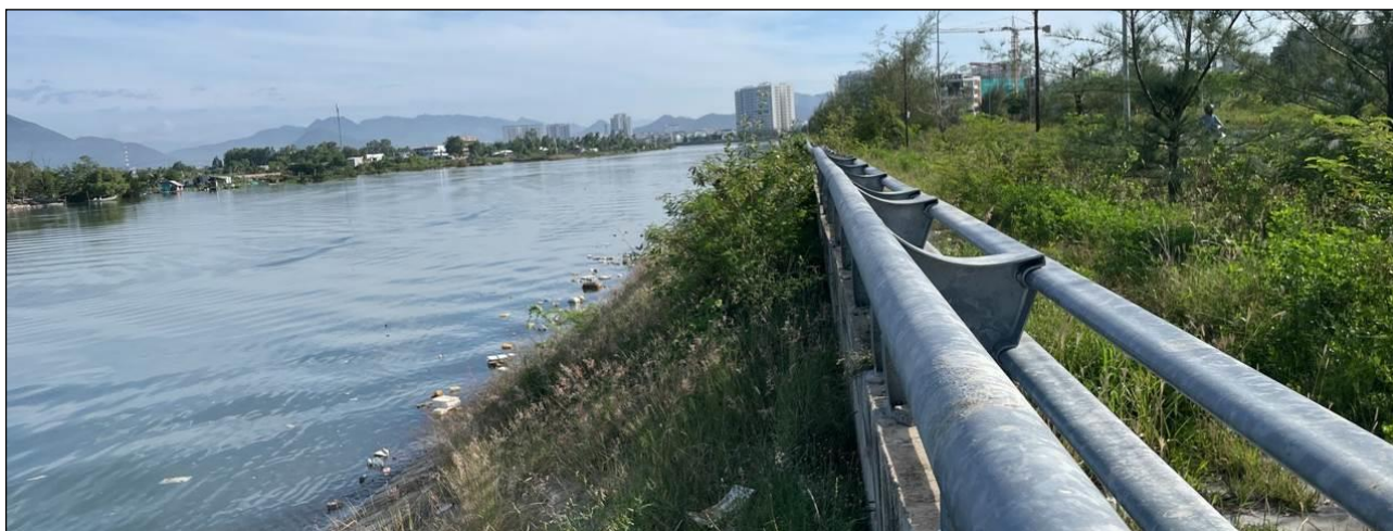
Hình 4. Kè sông Quán Trường (Đã xây dựng)
