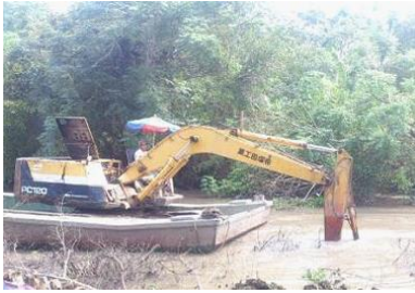
Máy đào gàu dây (đặt trên sà lan) thực hiện nạo vét
