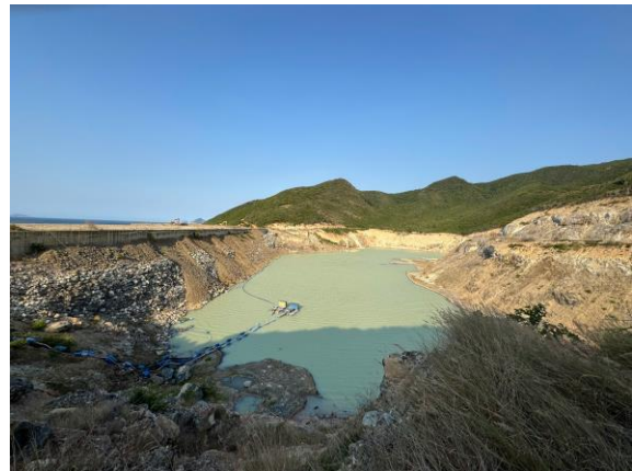
Hình ảnh hiện trạng hồ Bãi Rạn
