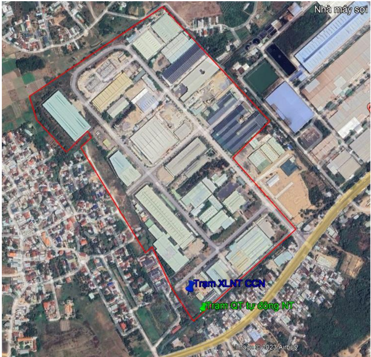
Hình 3.2. Vị trí trạm quan trắc nước thải tự động, liên tục CCN Đặc Lộc.
