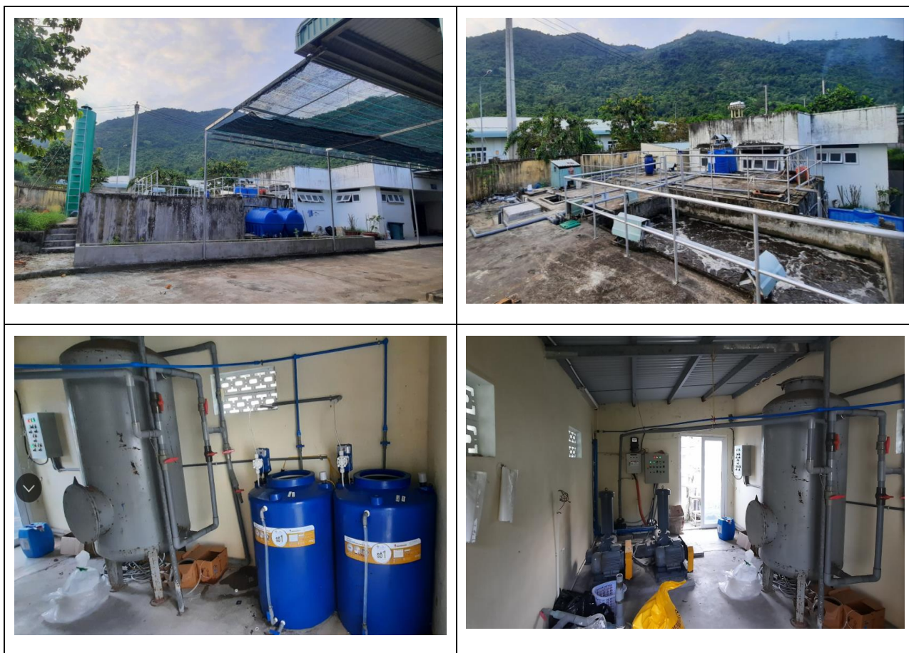
Hình 3. 5 Một số hình ảnh công trình hệ thống xử lý nước thải c. Hóa chất sử dụng
