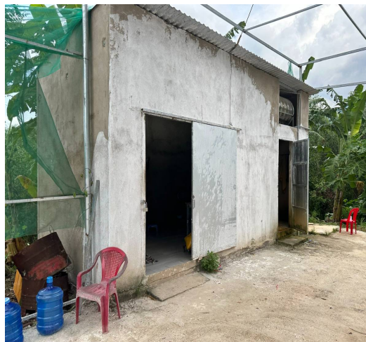
Hình 3.2. Nhà vệ sinh
