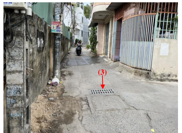
Ảnh 4. Vị trí đầu nối thoát nước mưa phía Tây (3) của dự án
