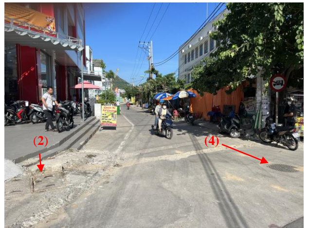
Ảnh 2. Vị trí đầu nối thoát nước thải (2) và nước mưa (4) đường Đặng Lộ - đường 2/4
