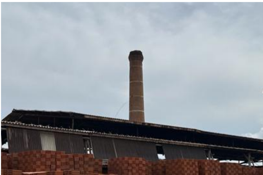
Hình 3.5: Ống khói thoát khí thải tại cơ sở
