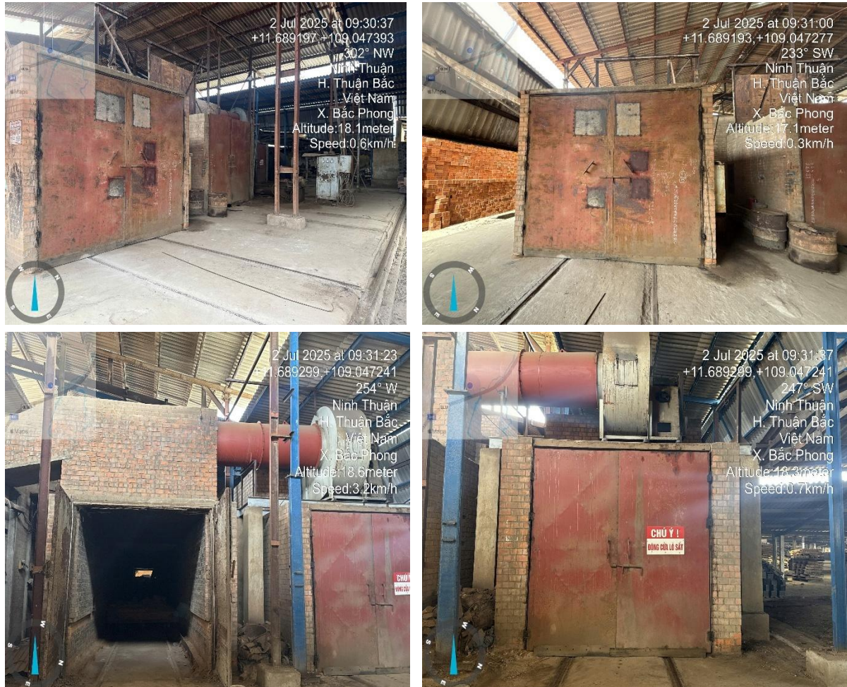
Hình 1.4: Lò nung và lò sấy tại cơ sở
