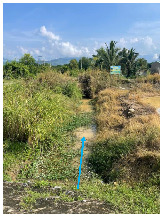
Mương đất dẫn nước ngang qua hồ cầu
