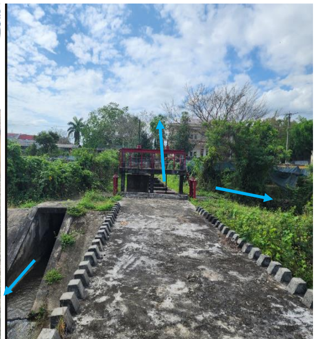
Cửa van kênh mương Cầu Đôi đoạn gần Cầu suối Muồng
