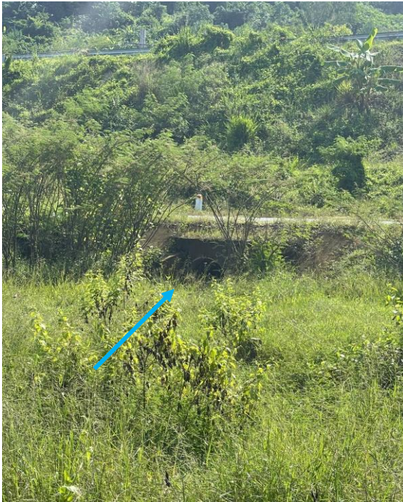
Cống bản dẫn nước băng ngang đường Hương lộ 62 dẫn về mương đất thoát vào cống bản băng ngang đường Quốc lộ 27C
