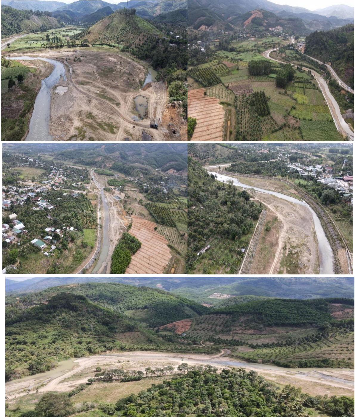
Hình 1. 5. Hiện trạng khu vực khai thác.
