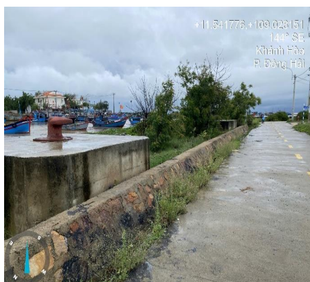
Hình 1.16: Hiện trạng khu vực tuyến kè kết hợp bích neo xây mới
