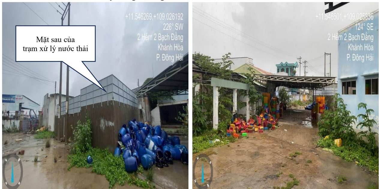
Hình 1.12: Hiện trạng khu vực Nhà vệ sinh xây mới
