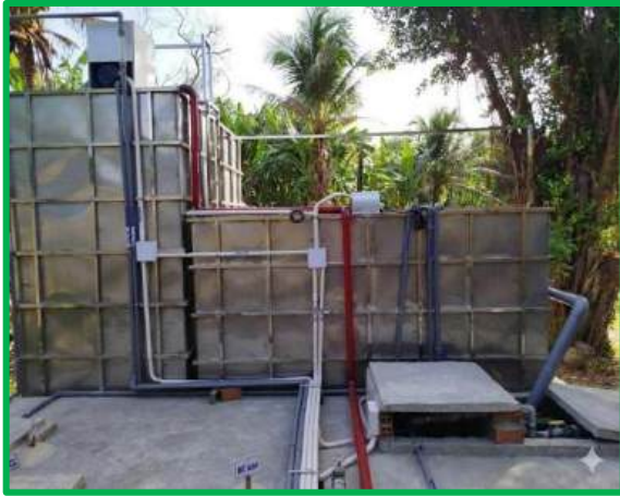
Cụm bể hệ thống xử lý nước thải
