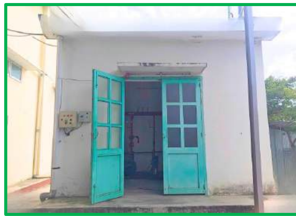
Nhà điều hành Hệ thống PCCC
