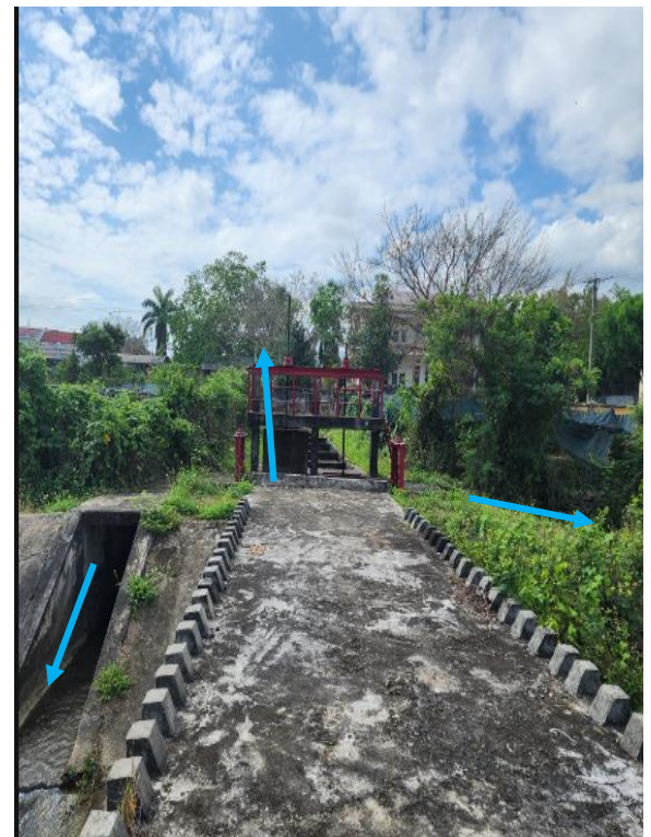
Cửa van kênh mương Cầu Đôi đoạn gần cầu Suối Muồng
