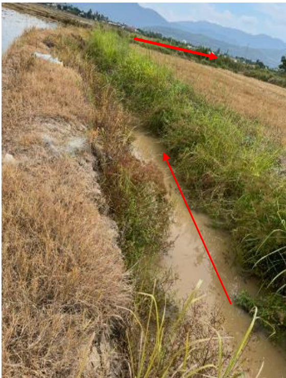
Mương đất dẫn nước về Cầu Suối Rút
