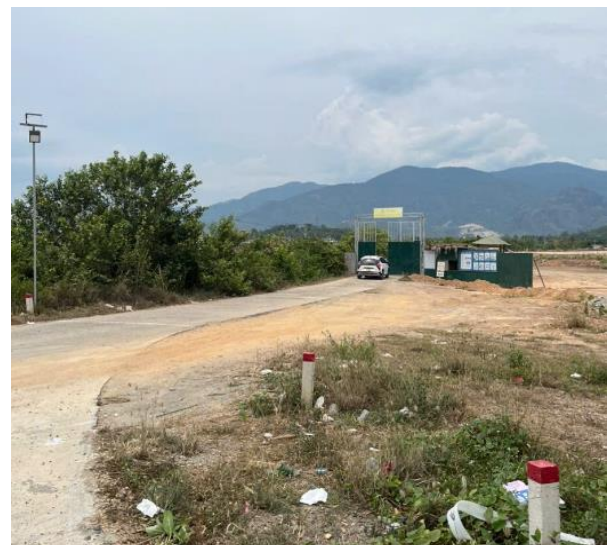
Đoạn giao QL 27C và đường cấp phối vào dự án (cổng GD2)
