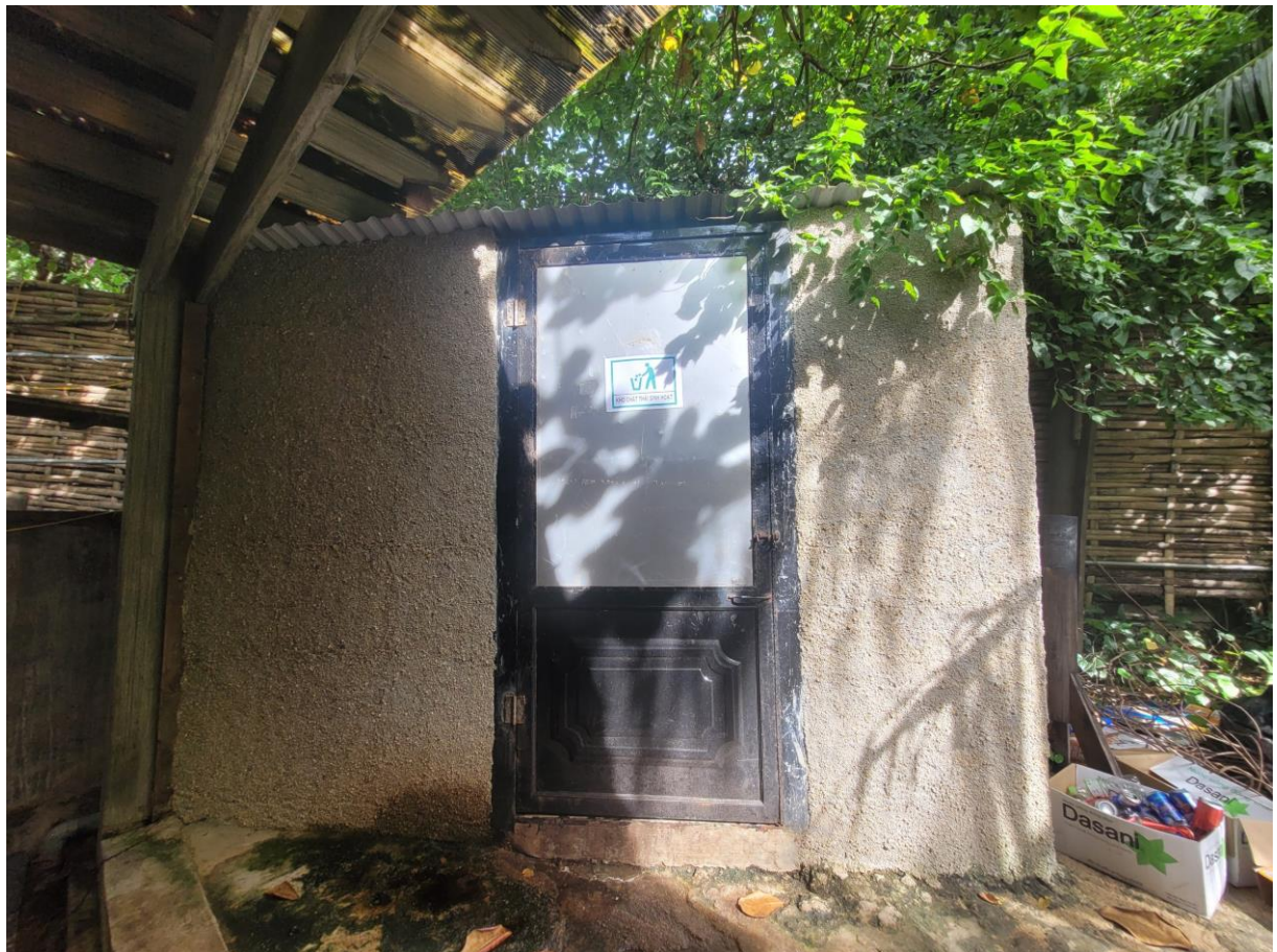
Hình ảnh kho chất thải sinh hoạt của cơ sở
