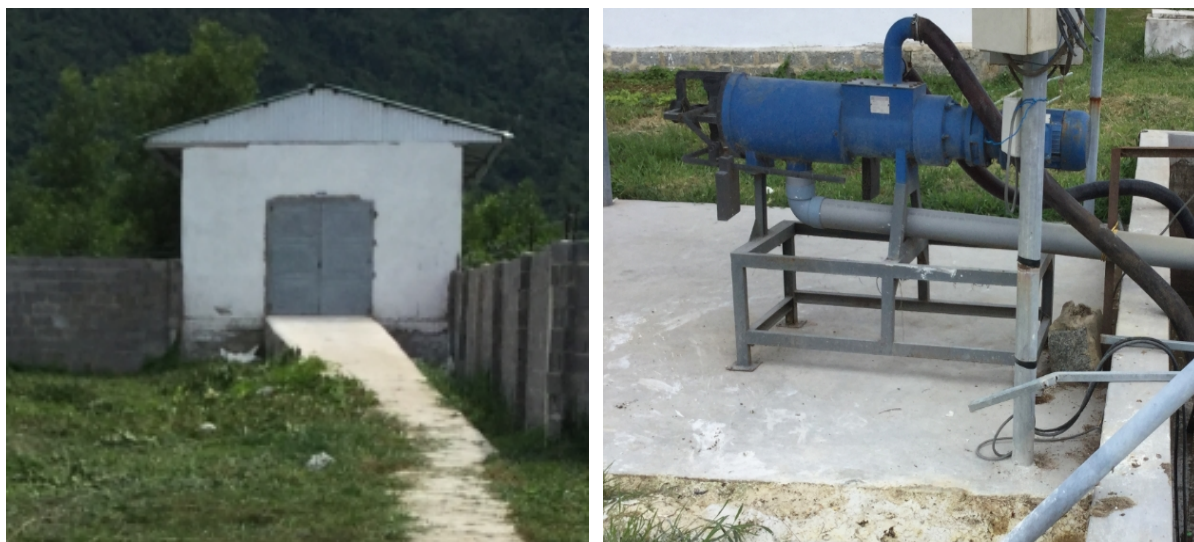
Hình 3.8. Kho lưu phân và thiết bị tách nước bùn thải
