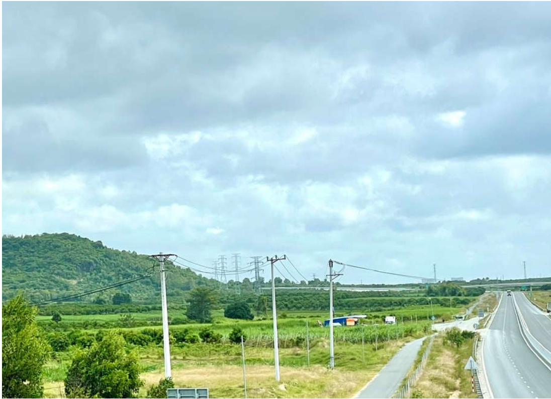
Hình 4.2: Hiện trạng khu đất xây dựng TDN tuyến bên phải
