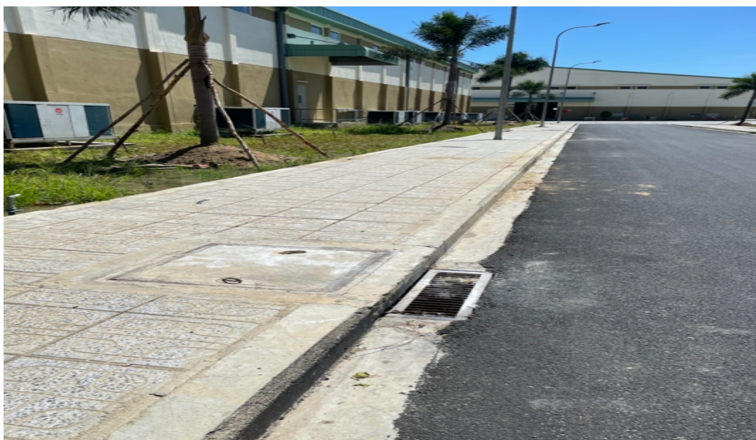
Hình 6. Hố ga thu gom nước mưa tại dự án
