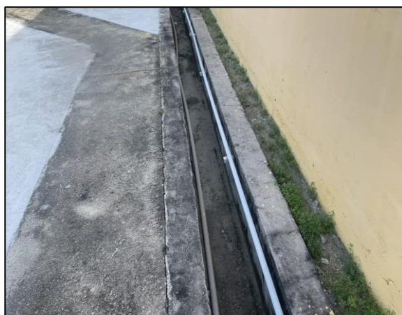
Rãnh thoát nước mưa B400
