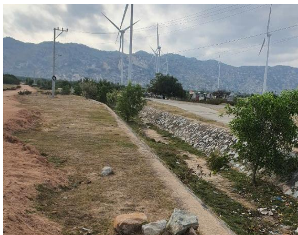
Rãnh đá xây tiêu thoát nước hiện hữu chạy dọc đường vào Khu vực Dự án
