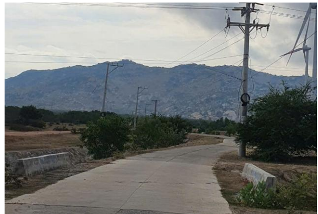
Đường BTXM hiện hữu vào Khu vực Dự án
