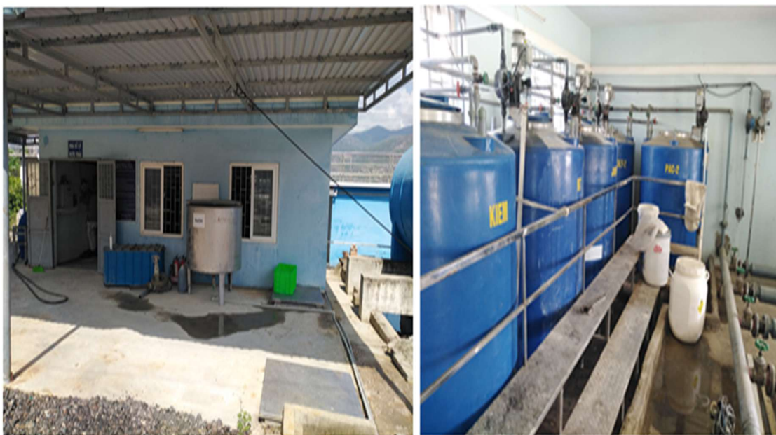
Hình 3.9: Nhà vận hành và các thùng hóa chất vận hành HTXLNT
