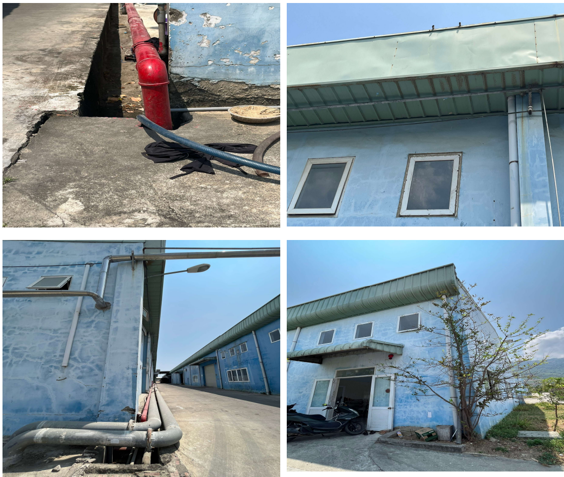
Hình 3.2: Thu gom nước mưa ở các xưởng và khu nhà ăn.
