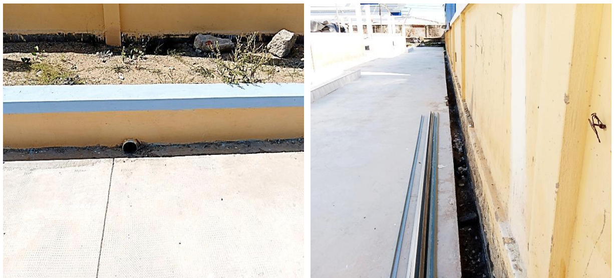
Hình 3.3. Hình ảnh rãnh thu gom nước mưa Khu C.
