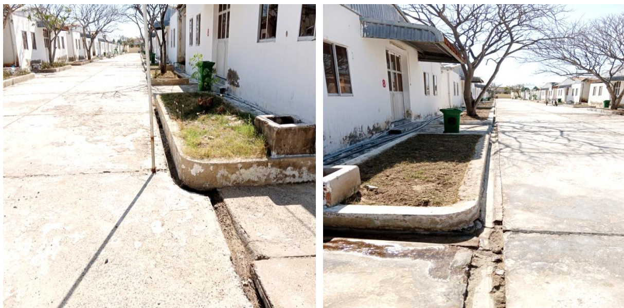
Hình 3.1. Hình ảnh rãnh thu gom nước mưa Khu A.
