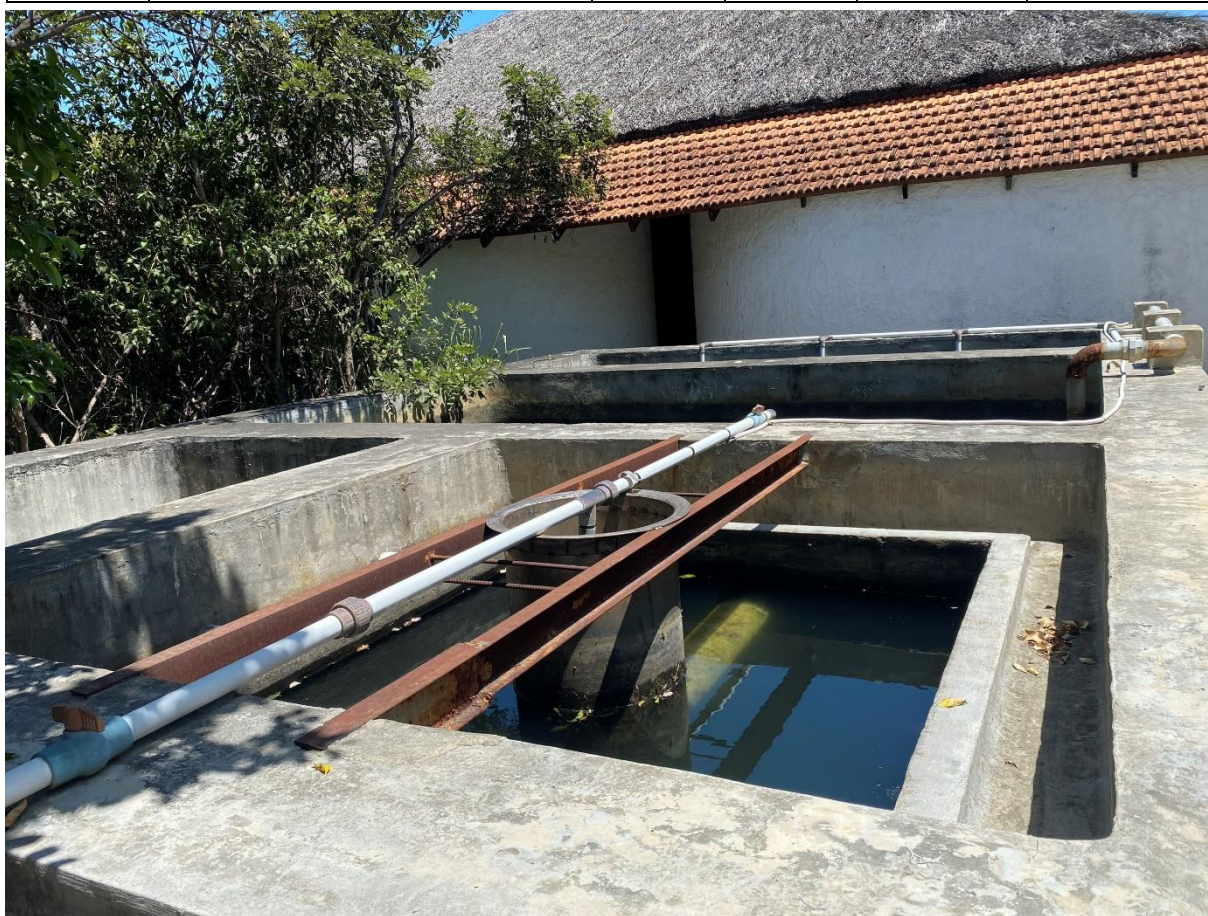
Hình 3. 5 Hiện trạng hệ thống xử lý nước thải tại cơ sở
