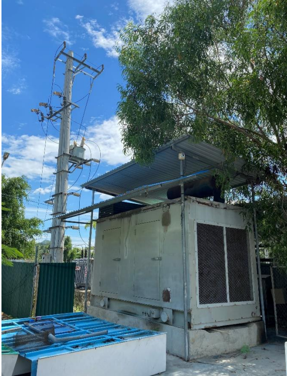
Nhà chứa máy phát điện
