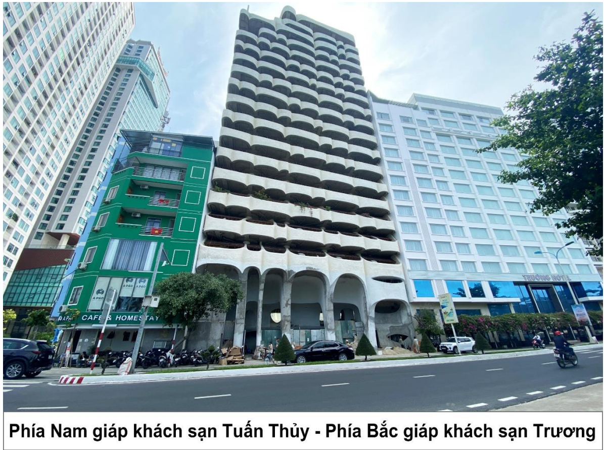
Hình 1.2 Hiện trạng khu vực dự án và xung quanh
