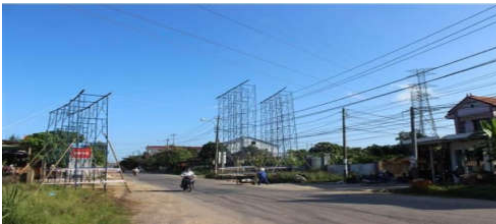
Hình 1.2: Sơ đồ minh họa giàn giáo vị trí vượt đường giao thông
