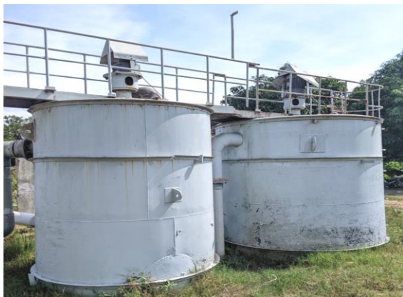
Hình 3.19: Bể keo tụ và bể tạo bông
