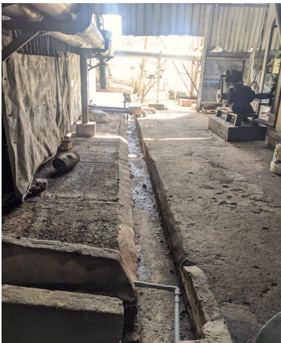
Hình 3.5: Mương bê tông thu gom nước thải rửa vỏ củ về bể lắng cát
