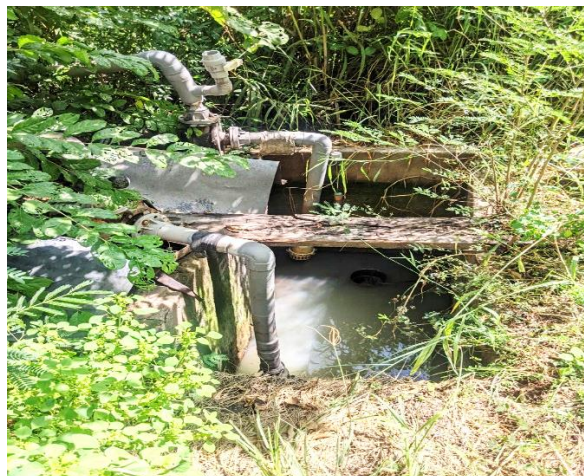
Hình 3.7: Hồ ga trung chuyển nước thải rửa vỏ củ
