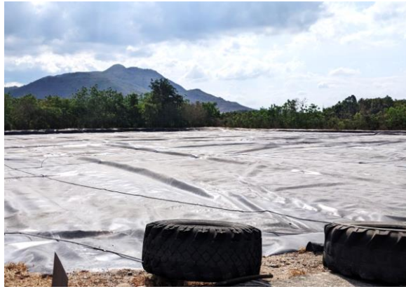
Hình 3.10: Hầm biogas
