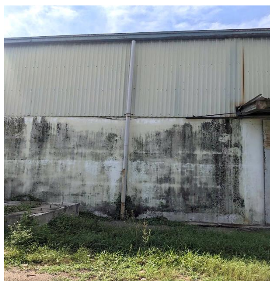
Hình 3.2: Thu gom, thoát nước mưa mái nhà xưởng sản xuất
