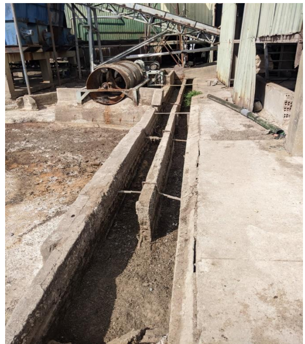
Hình 3.5: Mương bê tông thu gom nước thải rửa vỏ củ về bể lắng cát
