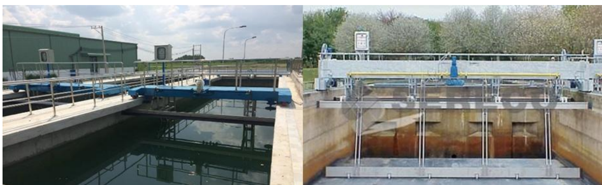
Hình 3. 16. Hình ảnh bể lắng sinh học
